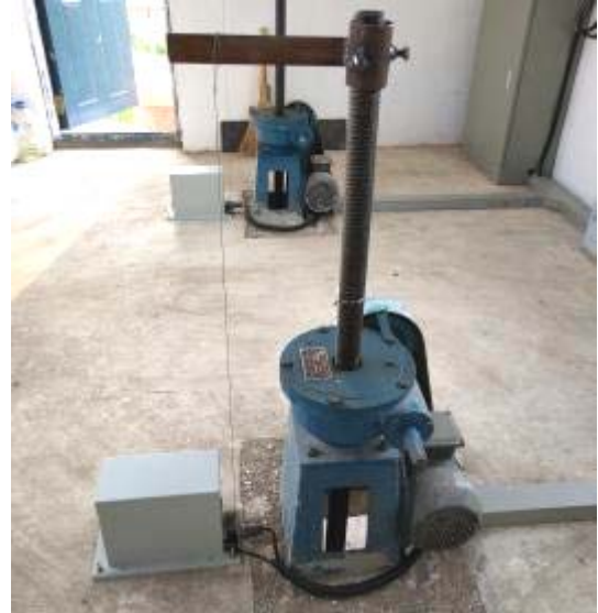
9、HZS 主令恒力收绳闸门开度传感器，螺杆式启闭机钢丝绳连接安装位置效果图：
