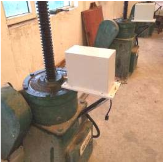
10、HZ-ZC 型轴承座式荷重传感器螺杆式启闭机安装位置图：
